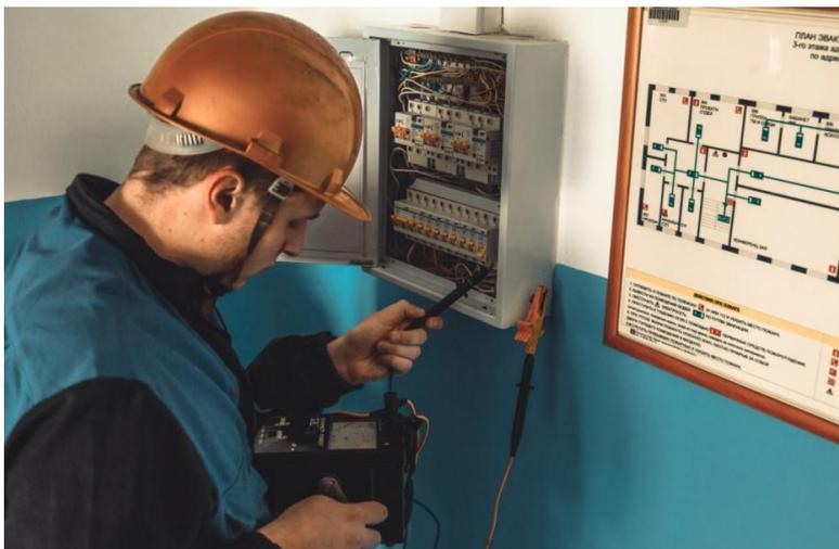
*Измерения проводятся для оборудования перед вводом в эксплуатацию, после текущего или капитального ремонта, а также в целях профилактики*
